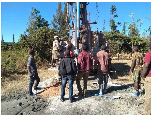
Brunnenbohranlage an der Sekundarschule in Haitemba. Einbau des prov. Unterwasserpumpe
