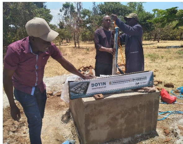
Brunnenbohranlage an der Sekundarschule in Haitemba. Einbau des prov. Unterwasserpumpe
